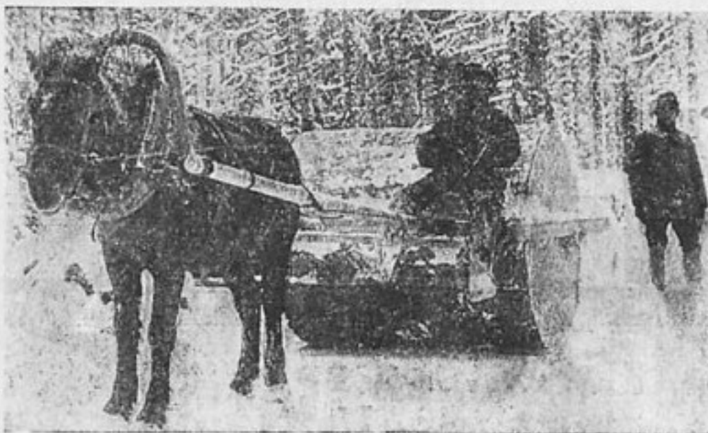
Укатка снежной дороги в Опаринском районе (Северный край) Фото Я. Мессина
