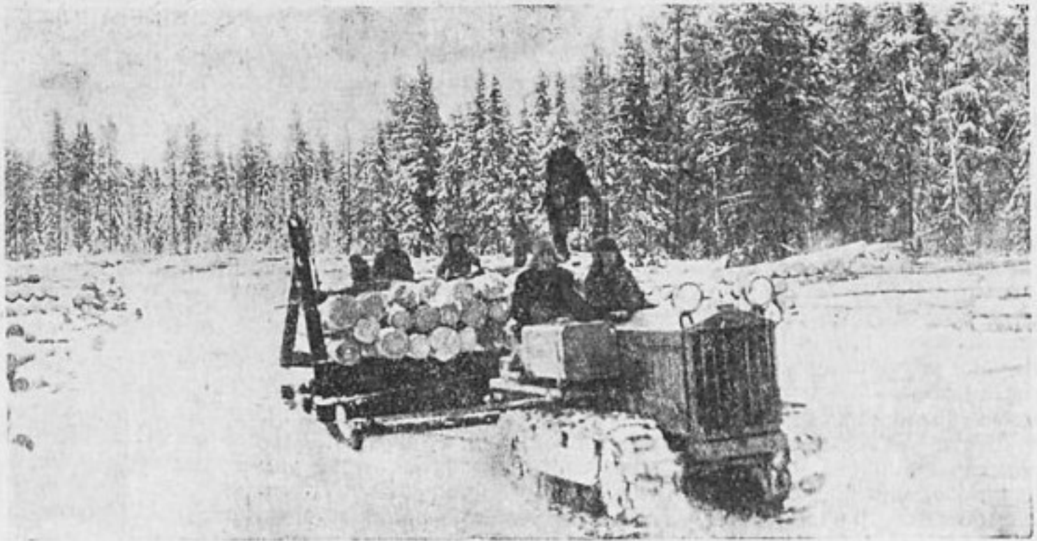
Подвоз леса по ледяной дороге на гусеничном тракторе (ст. Явеньга, Сев. ж. д.)
